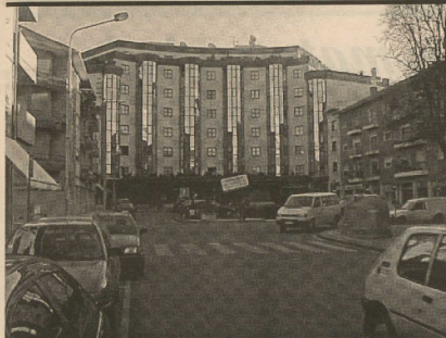
Ao fundo, o Praca do Dr. Alberto Souto, cruzada pela Rua do Engº Oudinot
