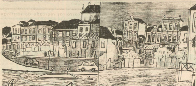
1965 - Demolição do velho casarão da Rua Clube das Galinhas para a construção da escadaria sobre o Canal Central e do edifício de serviços municipais, ambos inaugurados em 1970
