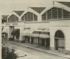
A recuperação do edifício do mercado Manuel Firmino vai preservar a arquitetura tradicional
