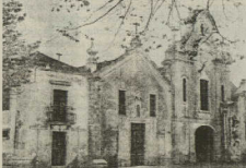
Fachada do conjunto Franciscano
