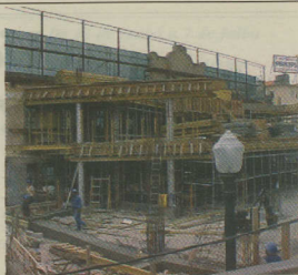
Obras de recuperação e beneficiação do Capitania
