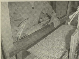
O pente do tear e as lançadeiras com as firas de farrapo são fundamentais para que o tapete seja bem tecido
