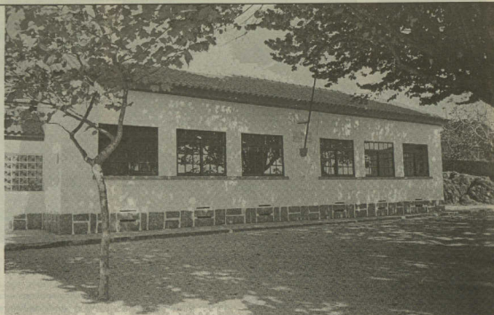
A escola do Farinheiro, em Fornos, Feira, recebeu obras de remodelação que a deixaram como nova
