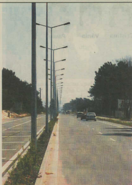
A Zona Industrial esta bem servida de acessibilidades
