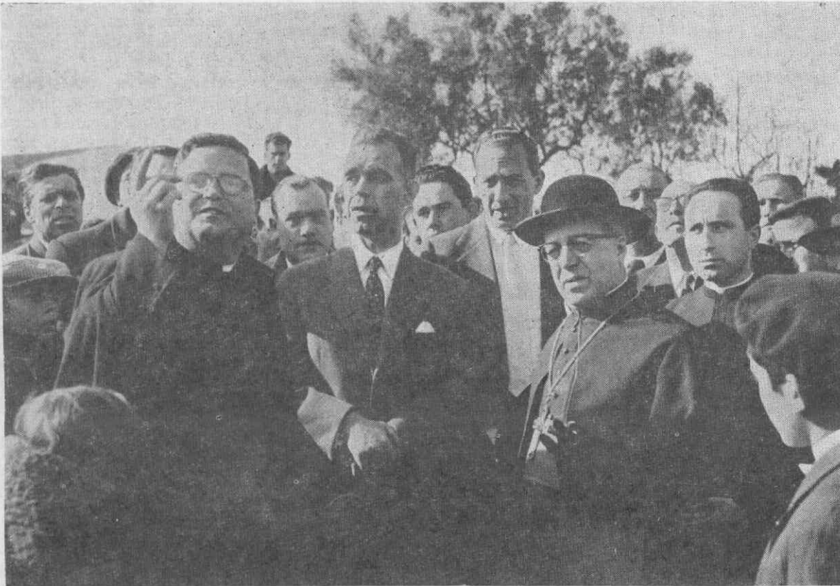
Uma visita de Sua Ex. a o Sr. Ministro das Obras Públicas, Dr. Arantes e Oliveira, às obras da nova igreja da Palhaça, acompanhado do Sr. Dr. Francisco do Vale Guimarães e de S. Ex. a Rev. ma o Sr. D. Domingos da Apresentação Fernandes, antigo Governador Civil de Aveiro e Vigário Capitalar da Diocese, ao tempo, respectivamente. O Rev. Padre Manuel de Oliveira, pároco da freguesia, dá informações aos ilustres visitantes sobre o andamento das obras que nessa altura se estavam a efectuar
