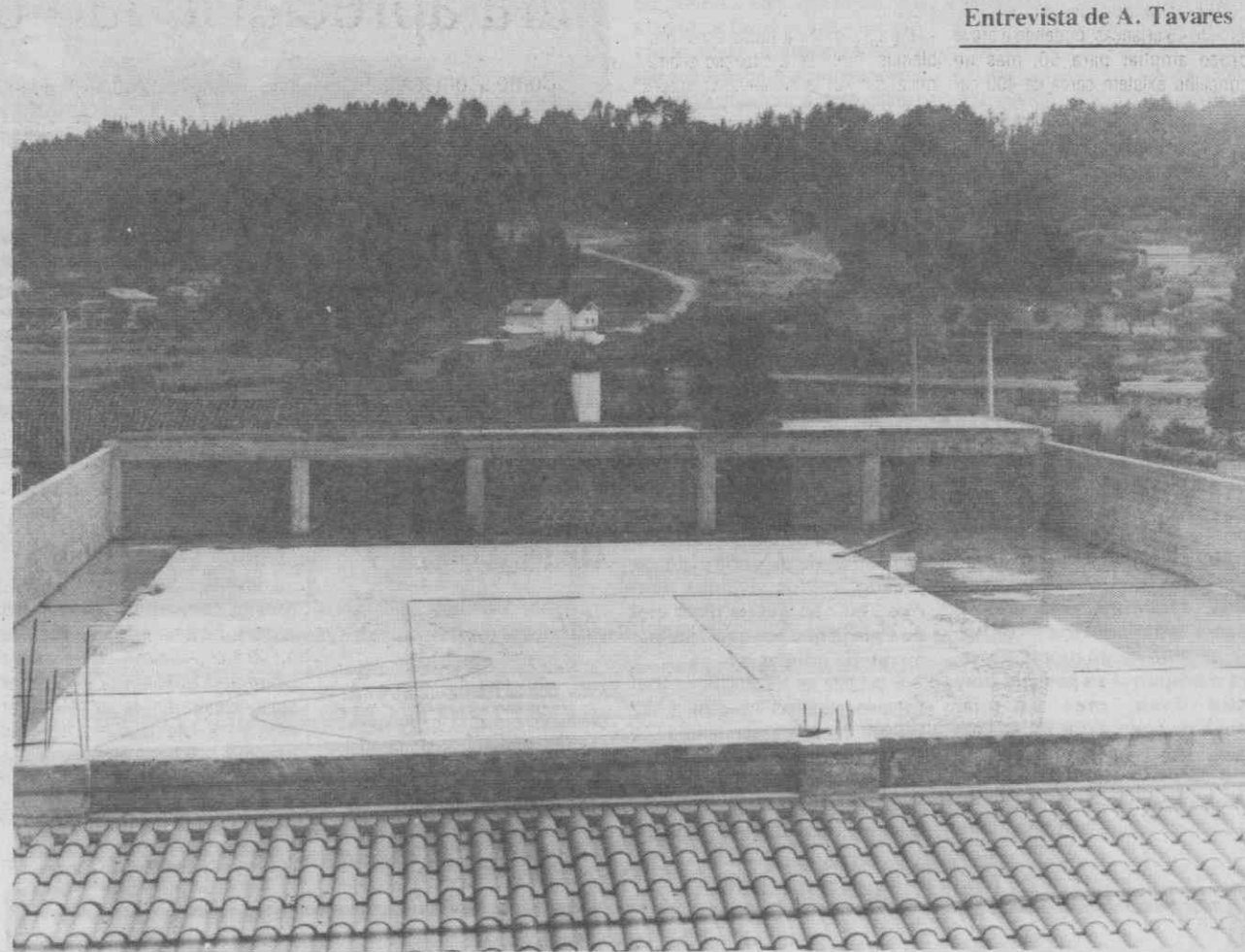
Pavilhão Polivalente, em construção, da Casa do Povo de Coja.
