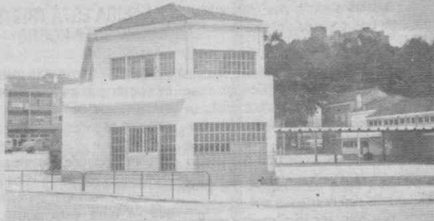
Edifício — Sede da Escola Preparatória de Pombal, cujos alunos vão assistir à Festa de encerramento da actividades lectivas.
