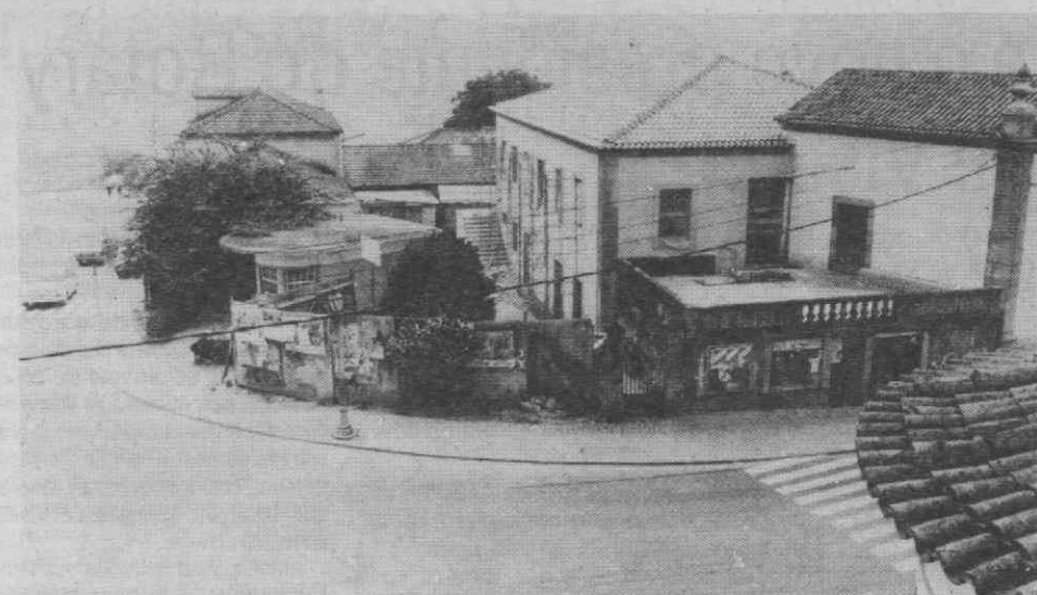
Aspecto das obras (paralisadas) da futura Repartição de Finanças.
