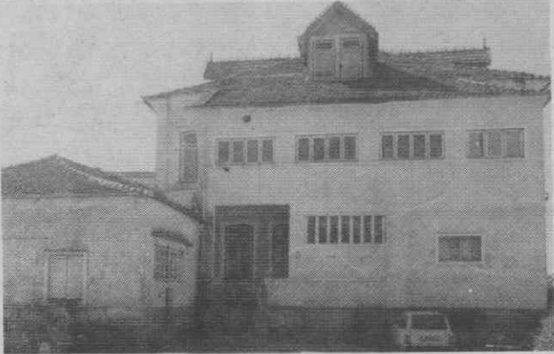
Aqui está ainda a funcionar a Câmara Municipal de Águeda. É o velho edifício do ex-colégio de S. Bernardo que dentro de algum tempo será demolido, segundo nos informaram.
