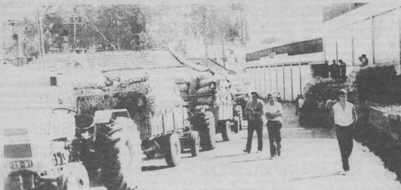
O «transbordo» foi feito mesmo na rua, dada a impossibilidade de acesso ao interior da fábrica.
