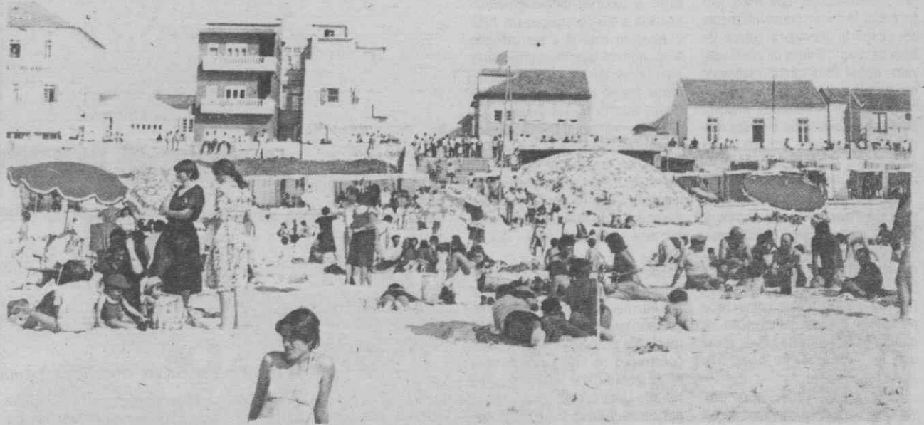
Praia de Pedrógão — muitas falhas a merecerem o devido reparo de quem de direito, na altura em que se comemora 150.º aniversário da localidade.
