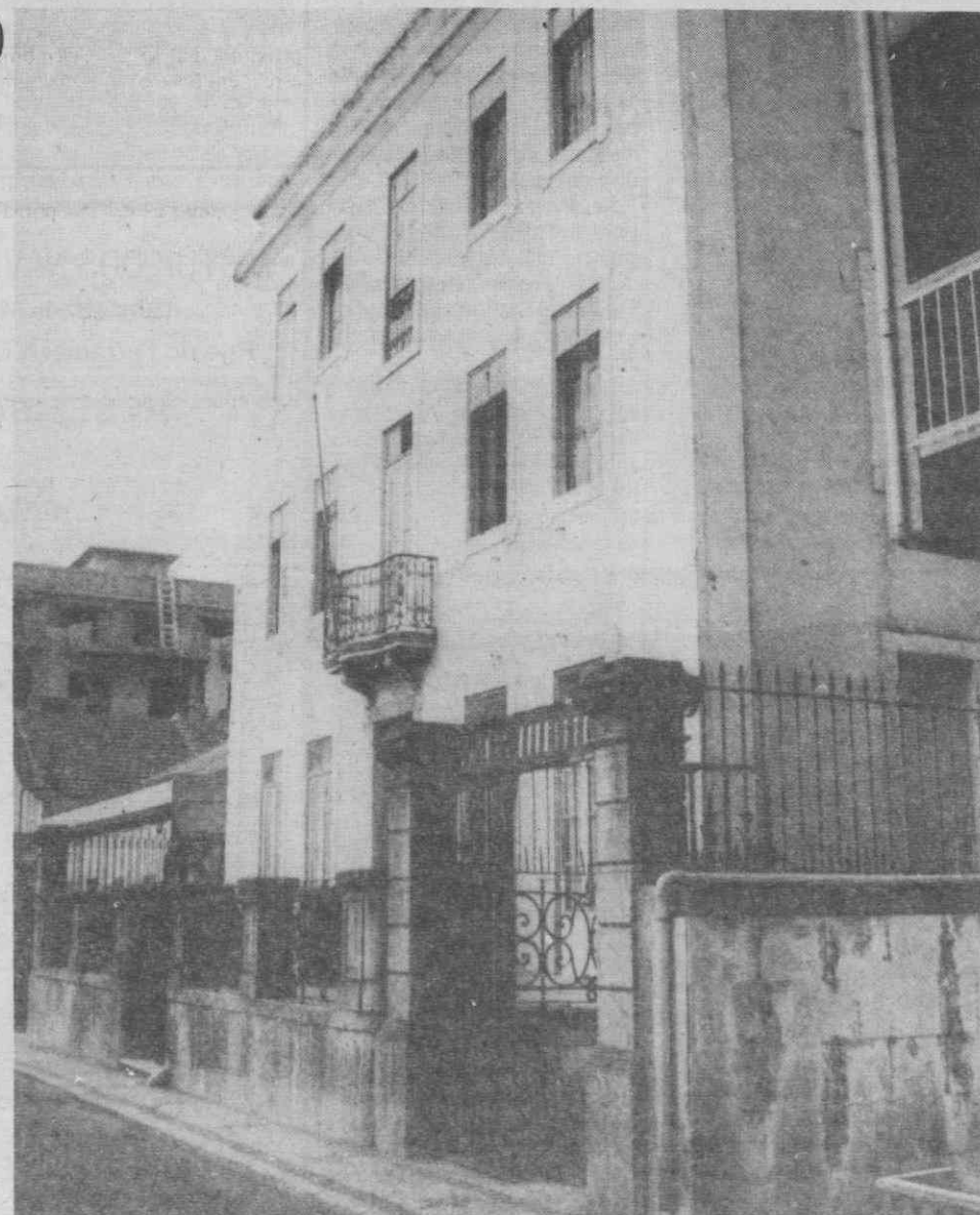
O edifício onde funcionou o Colégio de Santa Catarina, hoje ao abandono enquanto os estabelecimentos de ensino estão superlotados.
