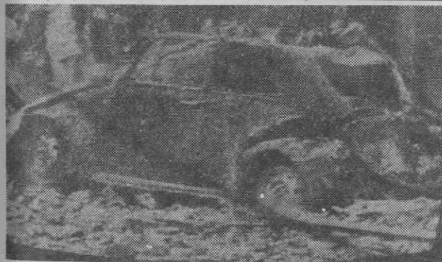
Foto tirada da televisão mostrando um carro destruído pelo desabamento de prédios vizinhos.
