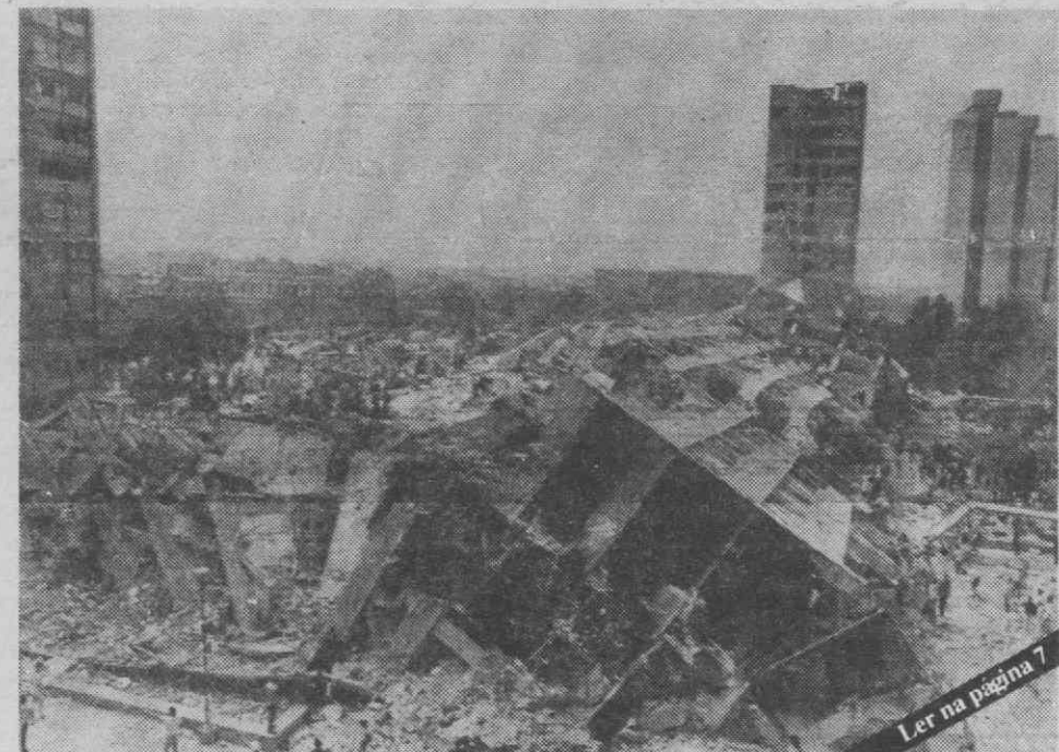
CIDADE DO MÉXICO — Aspecto da zona de Tlatelolco, vendo-se os destroços de alguns edifícios, após o terramoto. Telefoto Reuter/NP-«Diário de Aveiro».
