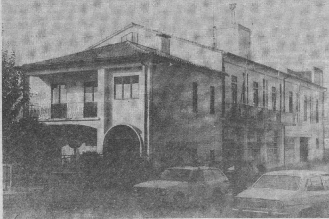
Aspecto do quartel dos Bombeiros de Águeda.
