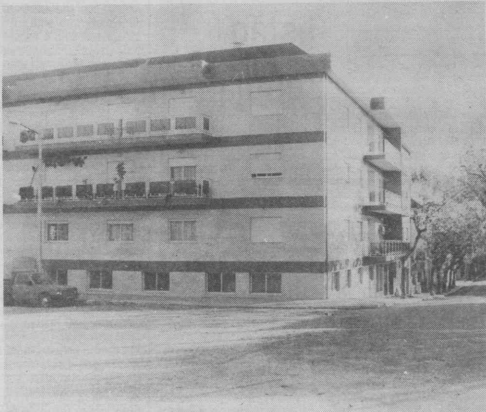
É neste prédio (rés-do-chão) que vai funcionar a nova clínica «Diagnosticum».
