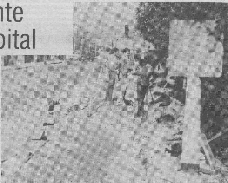
As obras de alargamento da E.N. 1 em frente ao Hospital prosseguem em bom ritmo.
