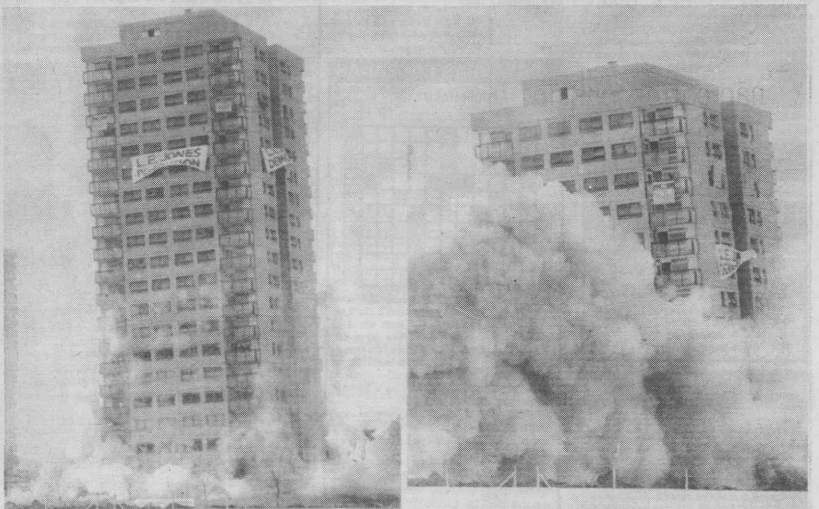
LONDRES — Combo de fotos mostrando as operações de demolição de um edifício de 21 andares.
