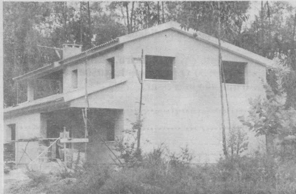
Uma das moradias em construção na urbanização de Travassô.
