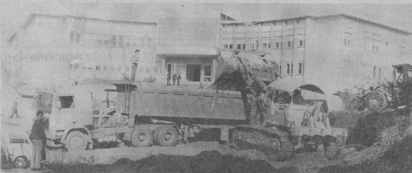
Um dos edifícios em construção
