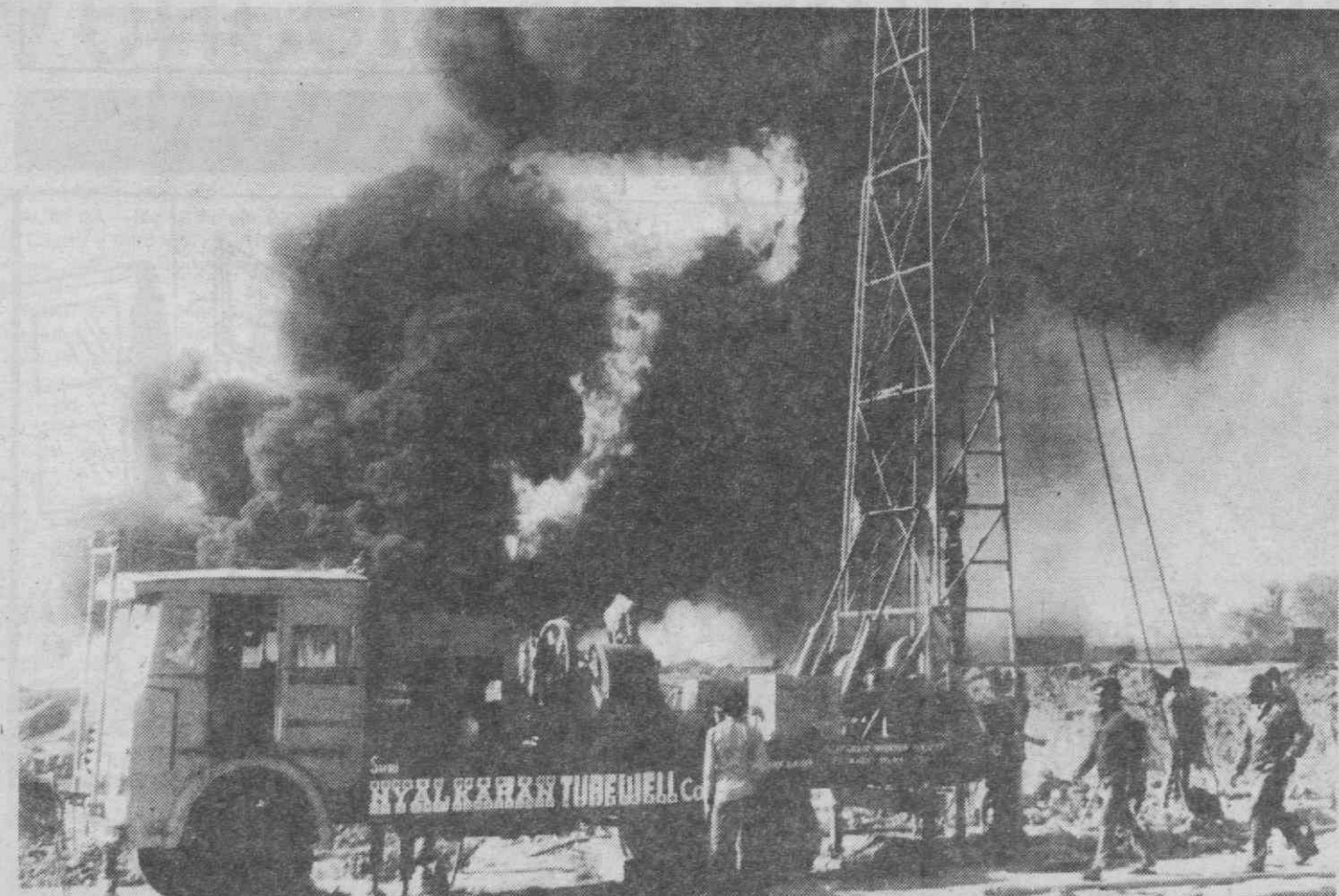
ÍNDIA — Aspecto dum gigantesco incêndio que deflagrou após explosão no equipamento de perfuração dum poço de petróleo. A explosão provocou prejuízos na ordem dos sete milhões de dólares.
