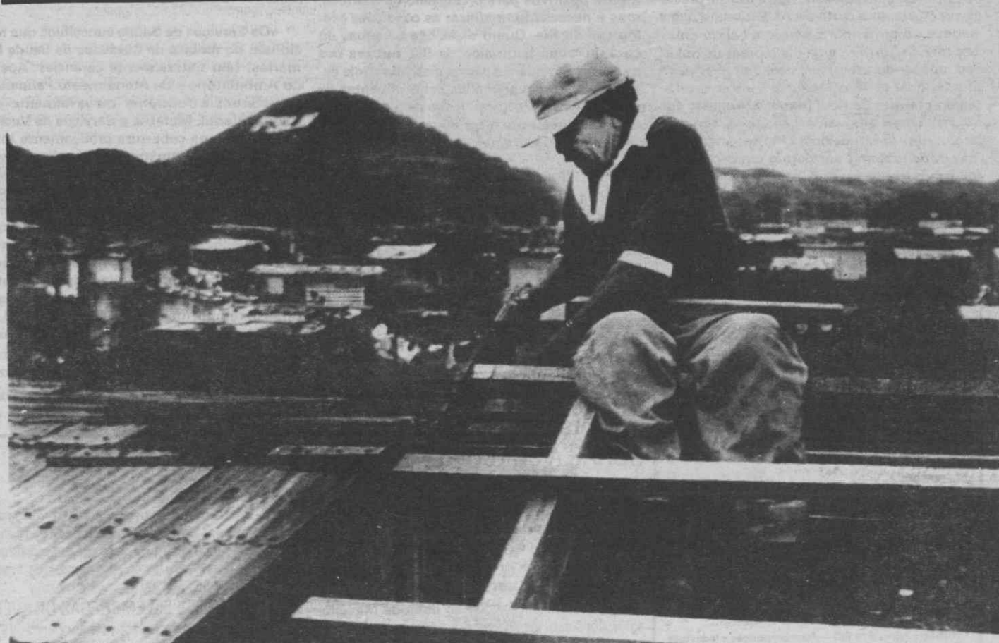
MANÁGUA (NICARÁGUA) — Um operário nicaraguense, de seu nome Nicolas Cordoba, atarefado a construir uma casa, para um seu familiar, num bairro, nos arredores de Manágua. Só nos últimos 9 meses, foram construídas nesta área cerca de 500 casas.
