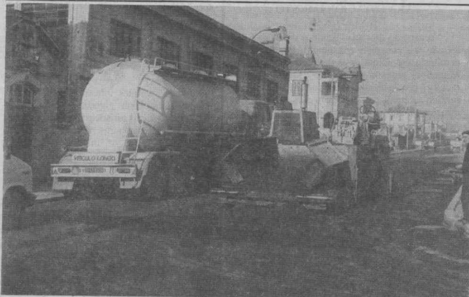
Aspecto das obras de pavimentação na EN 1
