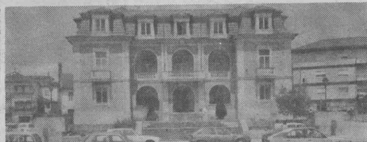
O edifício onde está instalada a Câmara Municipal de Nelas e onde funciona também a Coordenação Concelhia para a Educação de Adultos.
