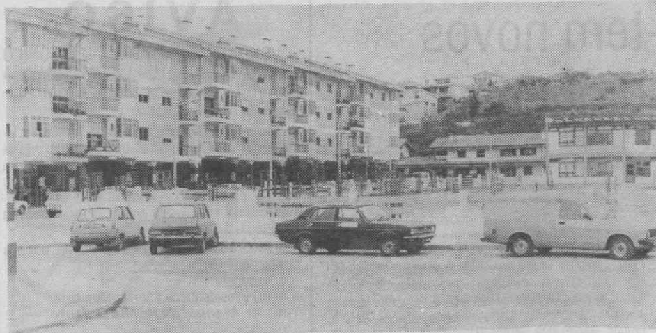
Urge pôr cobro a situações como a que a imagem mostra.
