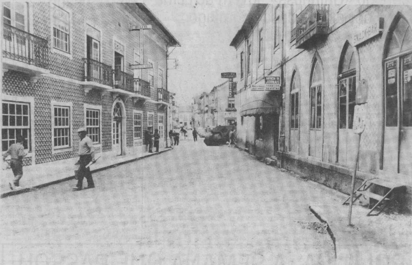
Aspecto dos trabalhos que decorrem no Largo do Botaréu.
