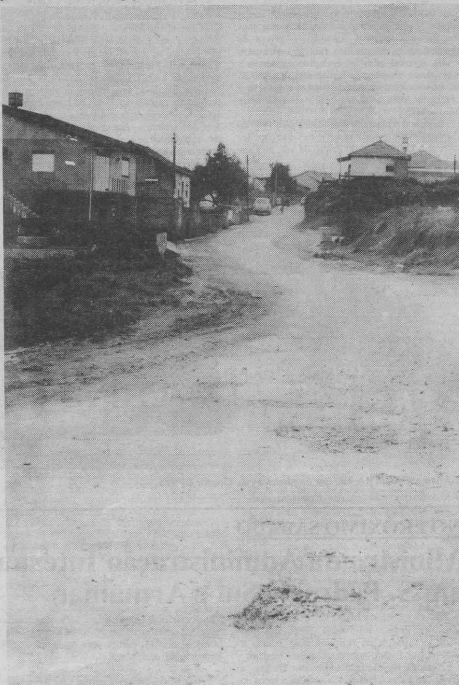
Aspecto da estrada que liga Trofa do Vouga à EN1.
