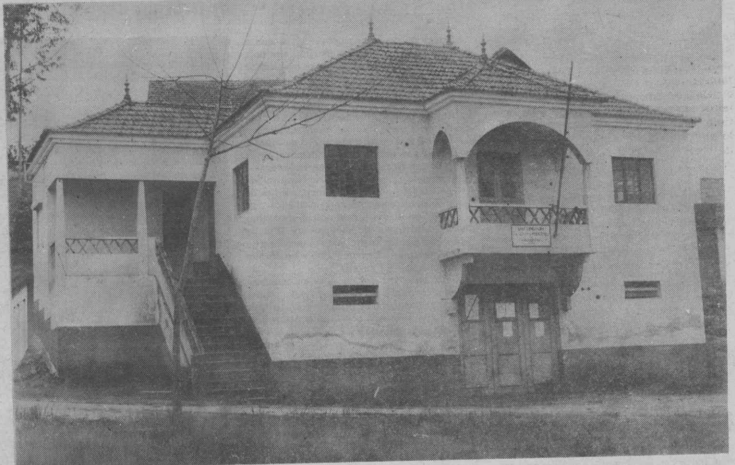
Imagem da fachada do edifício da Junta de Segadães.
