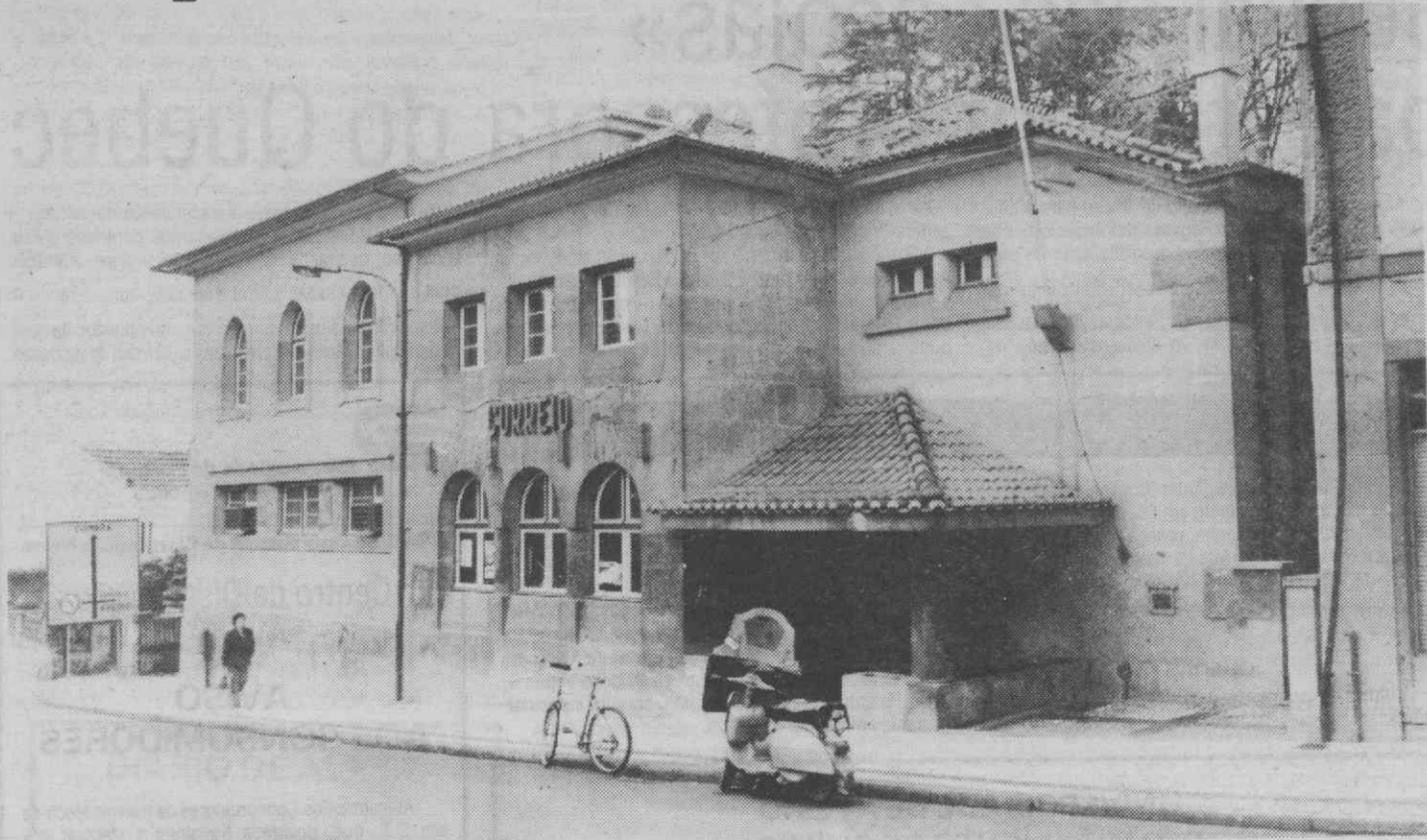
Aspecto das exiguas instalações dos Correios de Águeda.
