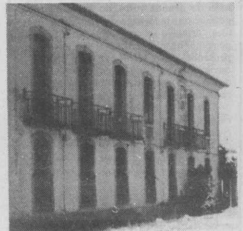
Aspecto parcial das traseiras dos Paços do Concelho.
