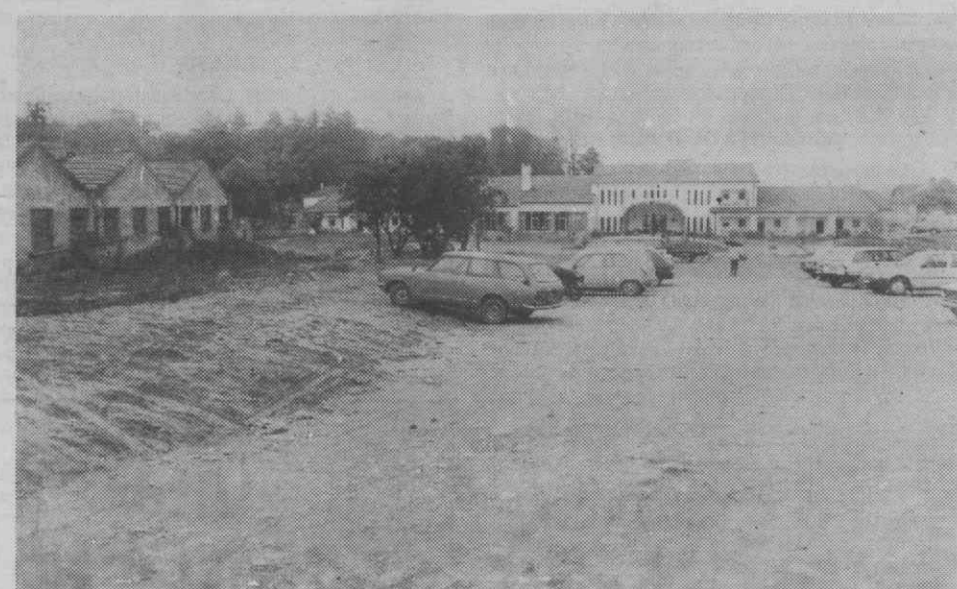
Esta imagem demonstra o contraste existente entre o excelente edifício do lar e os respectivos acessos.
