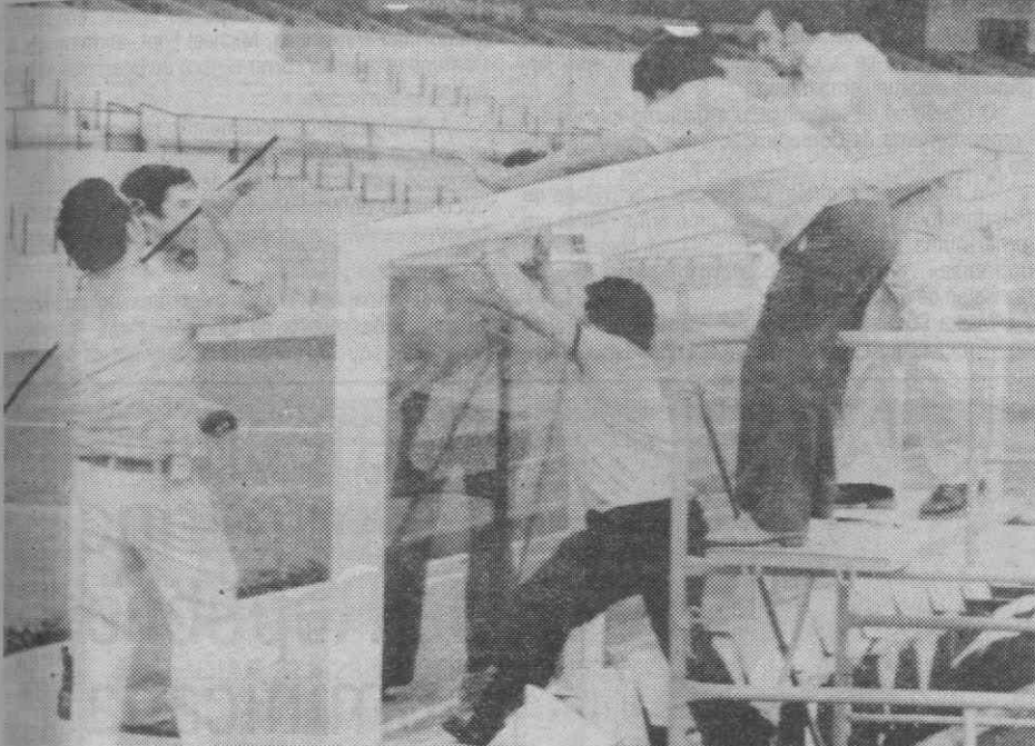
CIDADE DO MÉXICO — FUTEBOL: «MUNDIAL-86» — Funcionários do Estádio Olímpico, ultimam pormenores nos locais onde ficarão instalados os bancos dos suplentes, colocando vidros à prova de bala. (Telefoto Reuter/NP) «Diário de Aveiro».
