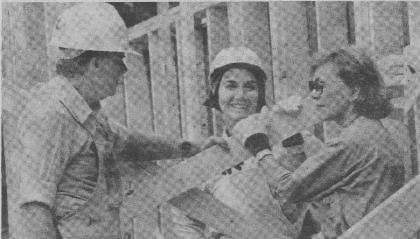
CHICAGO — O antigo Presidente dos EUA, Jimmy Carter e sua esposa trabalhando nas obras de construção de casas para pobres, juntando-se assim a cerca de 100 voluntários que ali vão trabalhar durante uma semana. (Telefoto Reuter/NP/«Diário de Aveiro».)
