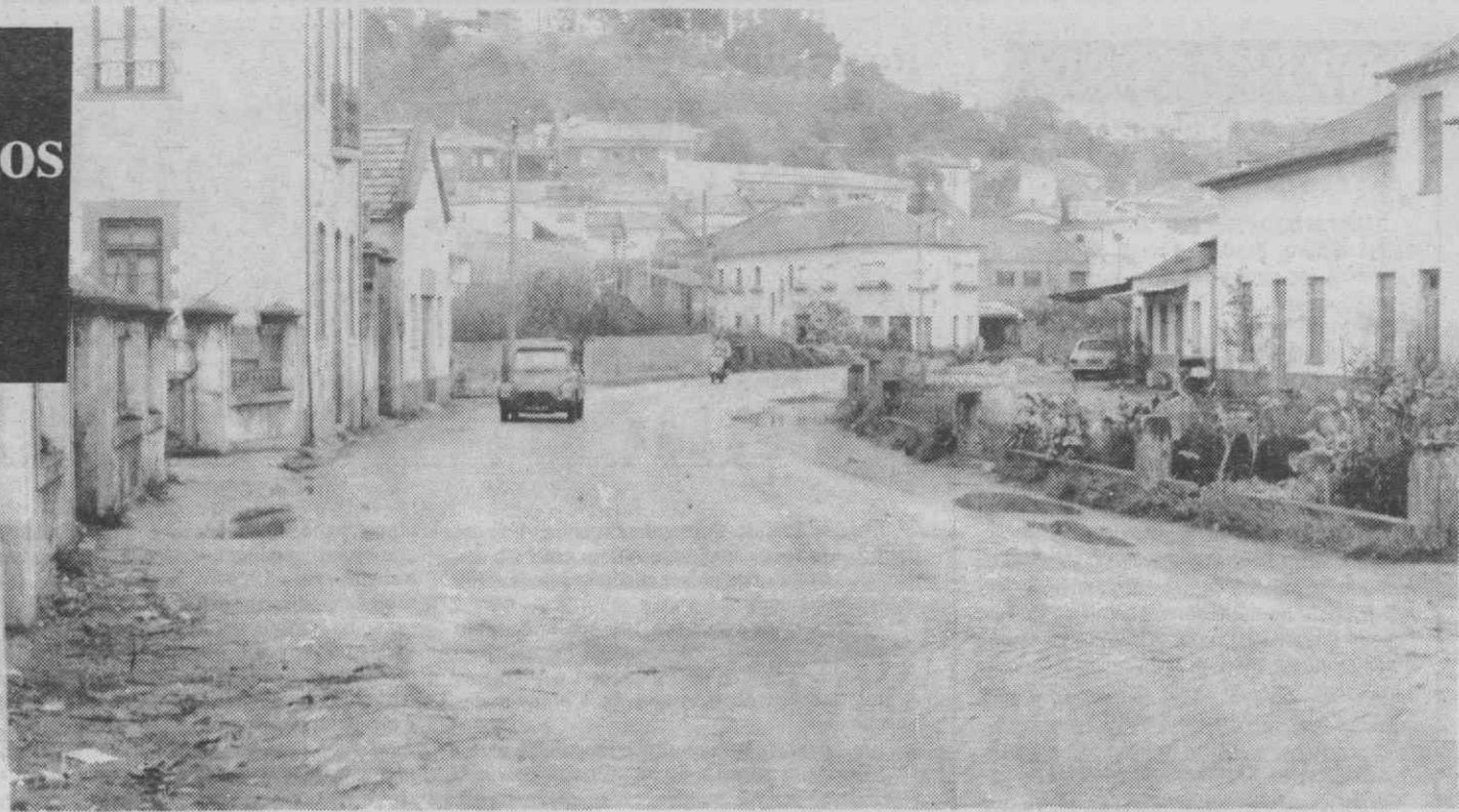
Aspecto da E.N. N.º 230, troço de Assequins.
