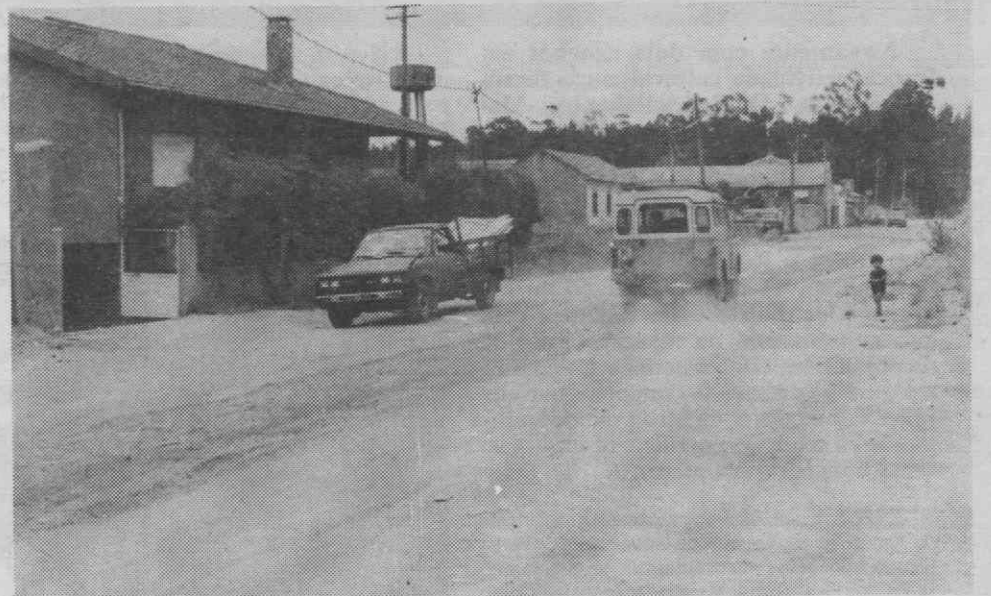
Aspecto do arruamento que dá acesso à freguesia de Valongo do Vouga.
