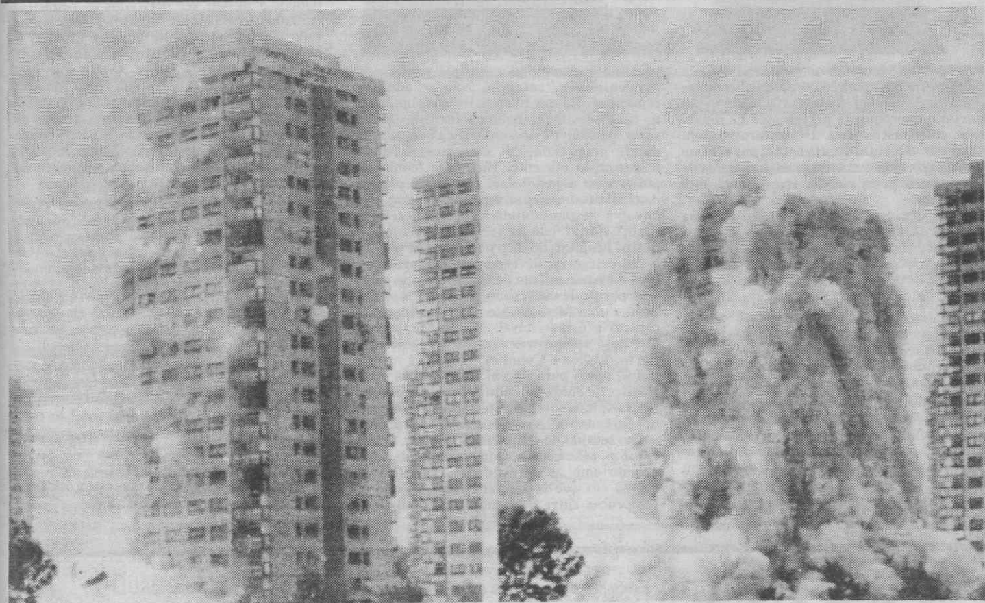
LONDRES — Combo de um edifício de 21 andares conhecido como Highworth Point, sendo demolido por meio de explosivos.
