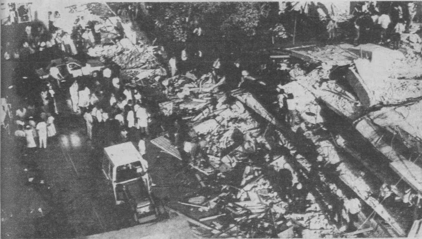
KALAMATA — Vista geral de escombros de edifício de oito andares que ruiu devido ao tremor de terra.
