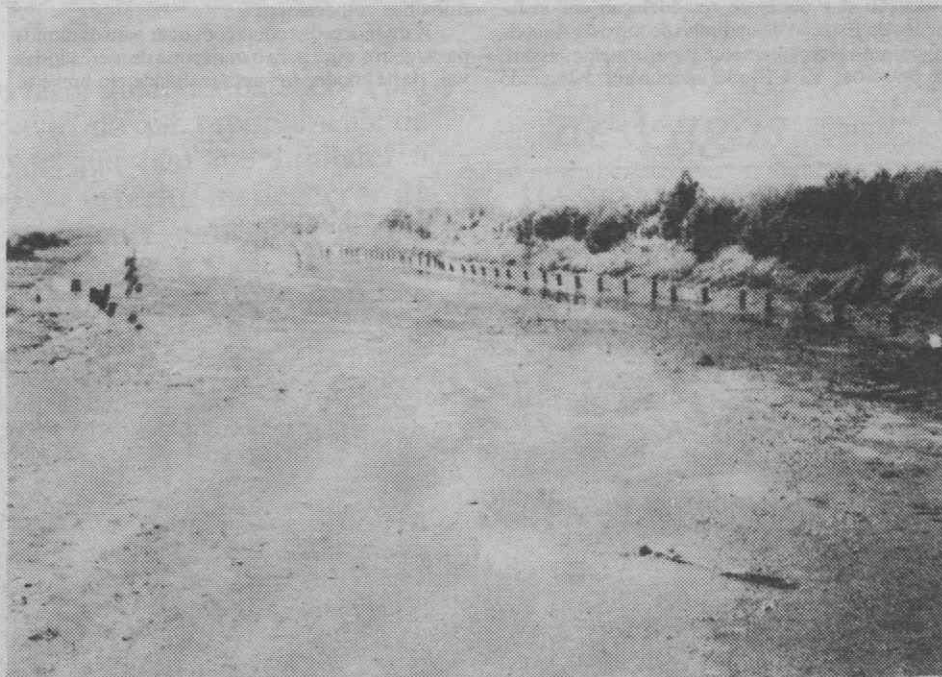
A foto mostra o assoreamento do esteiro.
