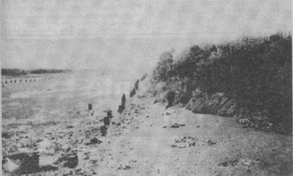
O «canal» em perfeito estado de degradação.
