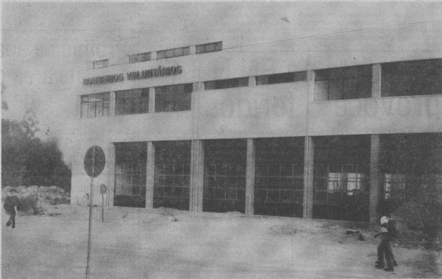
O novo quartel dos Bombeiros de Vagos, em fase de conclusão de obras.
