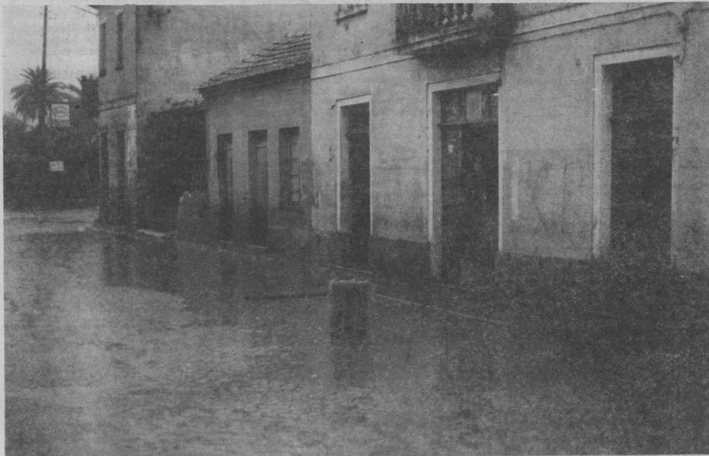
O proprietário deste estabelecimento comercial colocou um caixote na faixa de rodagem para impedir a circulação de veículos na enorme poça de água existente à entrada.
