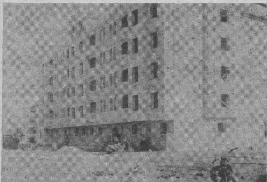
Edifício em construção na zona das Barrocas.
