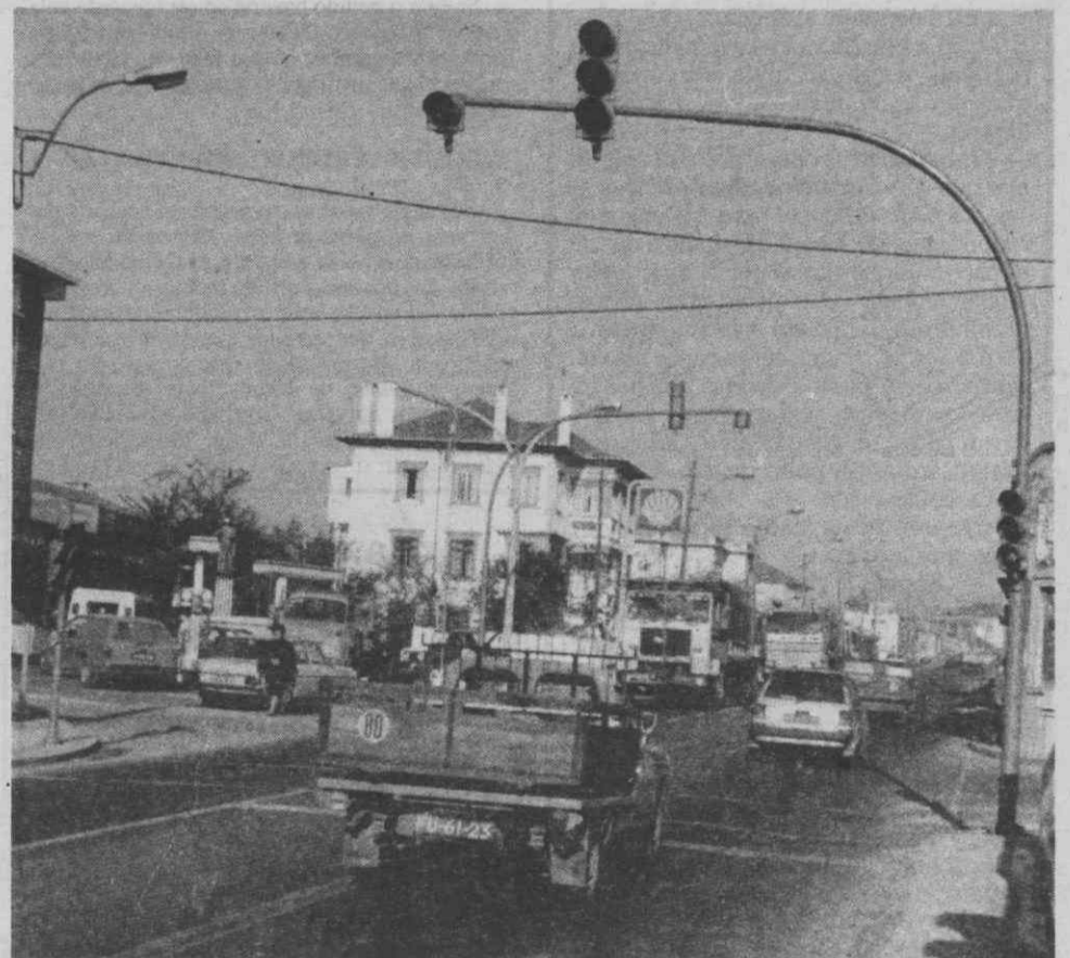
A rede semafórica começou já a funcionar. Na imagem um dos cruzamentos semaforizados, junto ao Hospital de Águeda.
