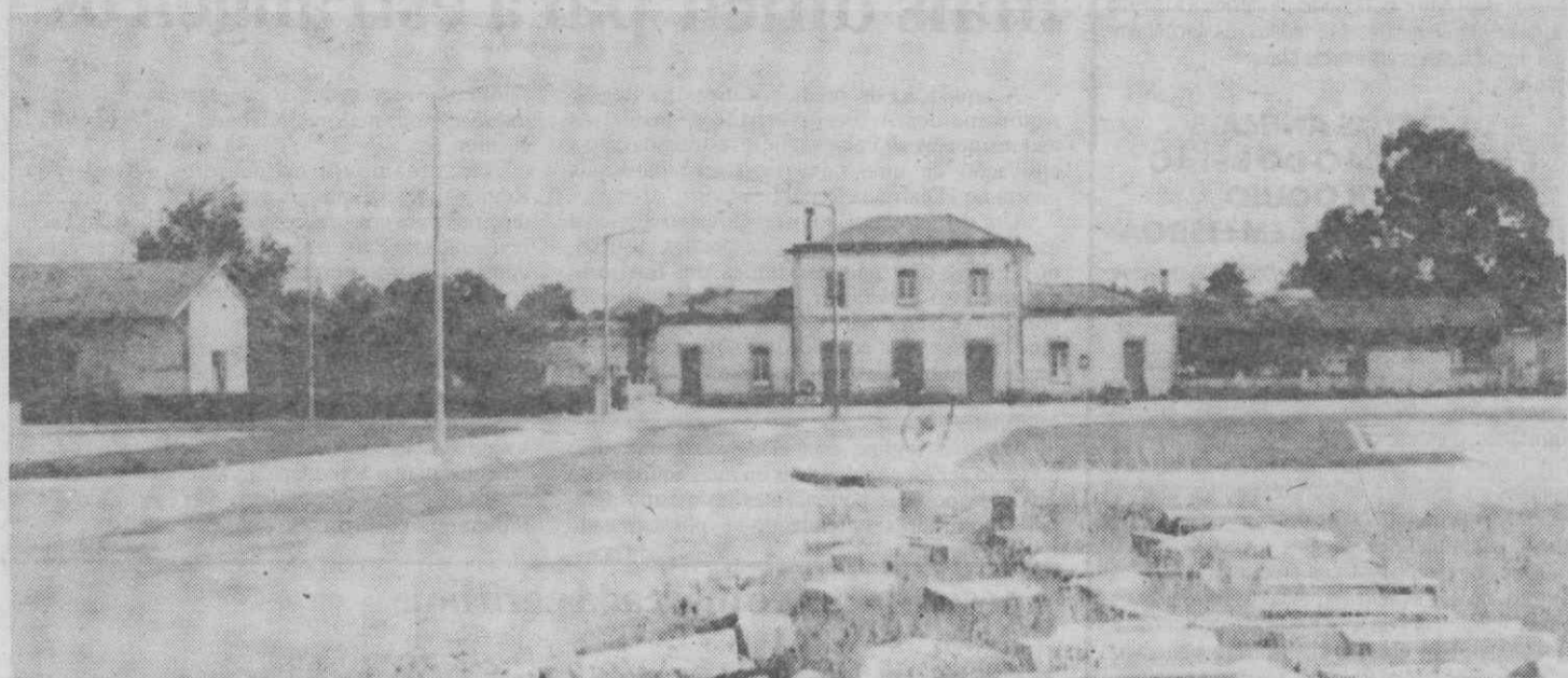
Ao fundo o edifício centenário da estação de caminho-de-ferro de Cantanhede, com o seu cais de armazenamento e outros anexos, e em primeiro plano as obras estéticas feitas à sua frente pela Câmara Municipal.
