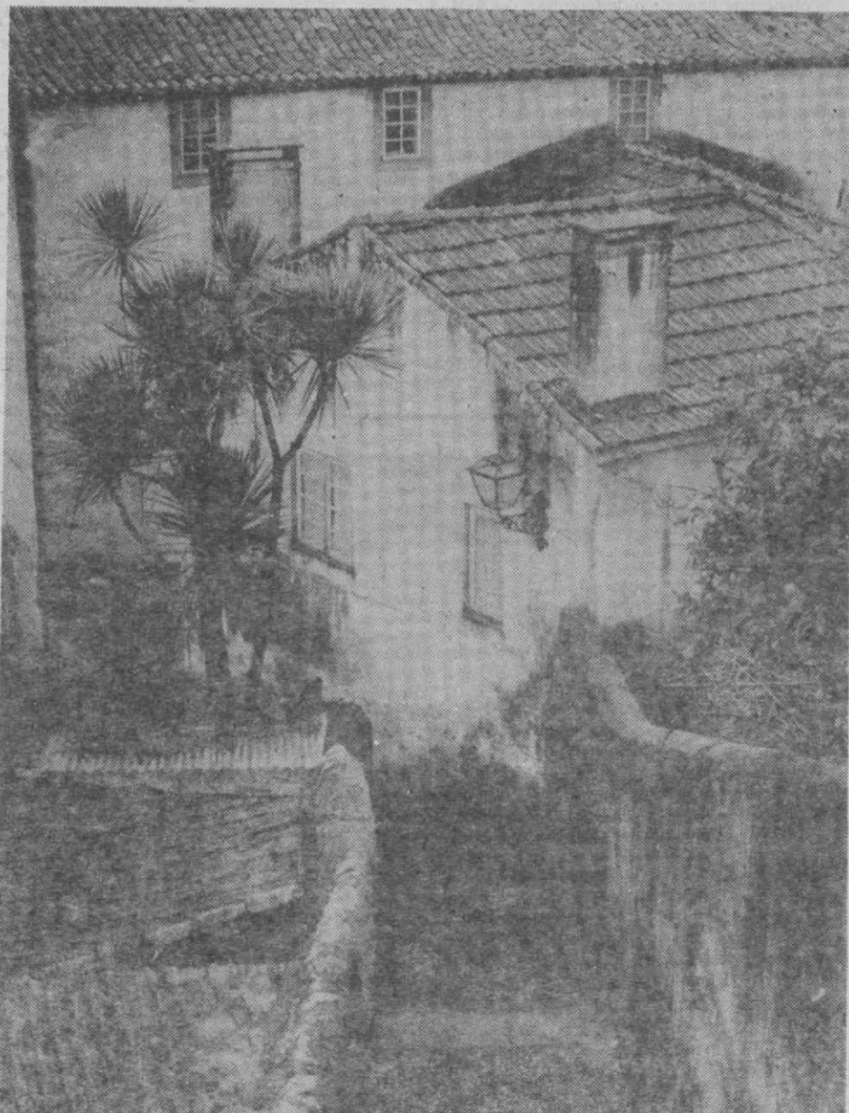
A zona do Adro, uma das que integram o plano de reabilitação urbana.
