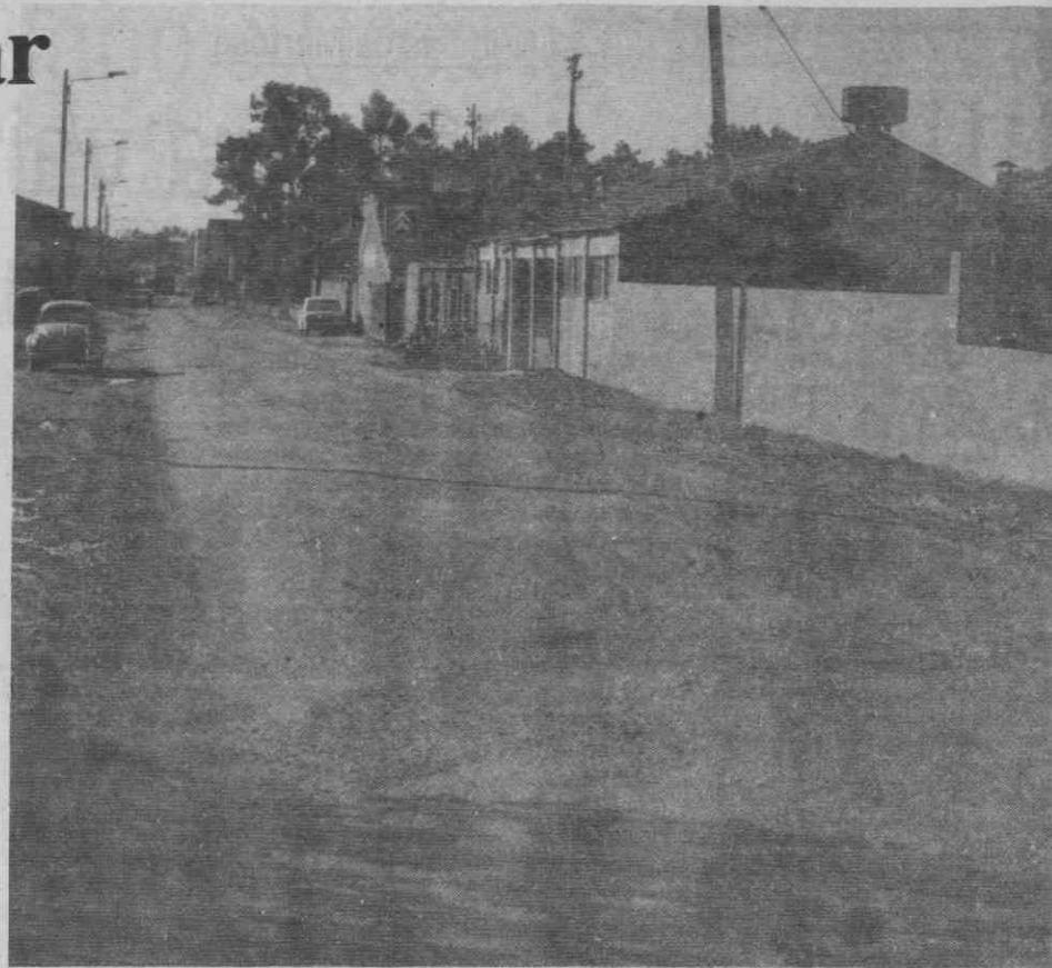
Um aspecto da estrada de ligação entre a EN N.º 1 e a freguesia de Valongo, junto do Bairro da Alagoa.
