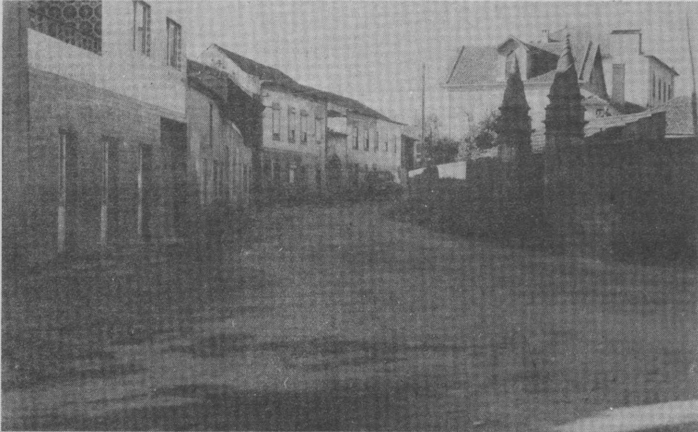
Este é um dos acessos ao nó das Talhadas, através de Arrancada do Vouga. Como se pode ver, a estrada não reúne o mínimo de condições.
