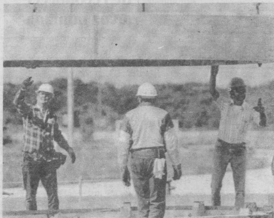
CABO CANAVERAL — Operários da base da força aérea local preparam-se para baixar uma viga de 10 toneladas de cimento, suspensa por cabos de aço, sobre os dois silos dos mísseis Minuteman que foram utilizados para armazenar os destroços do vaivém 'Challenger'.
