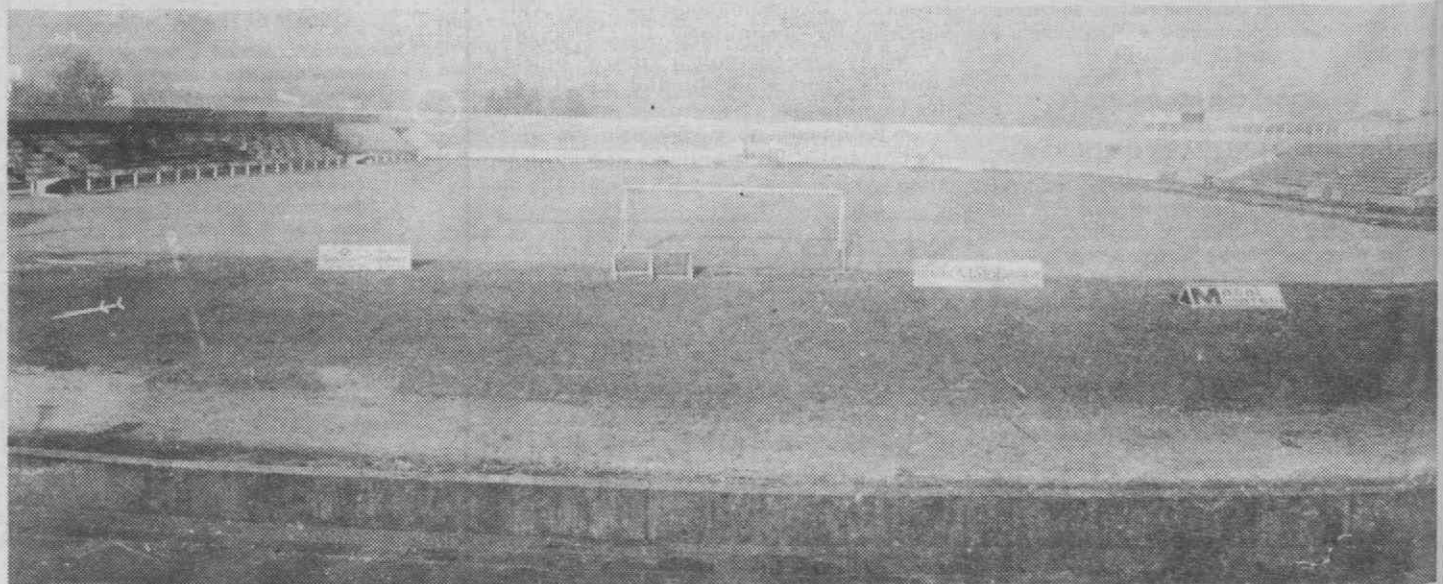
Aspecto do Estádio Municipal.
