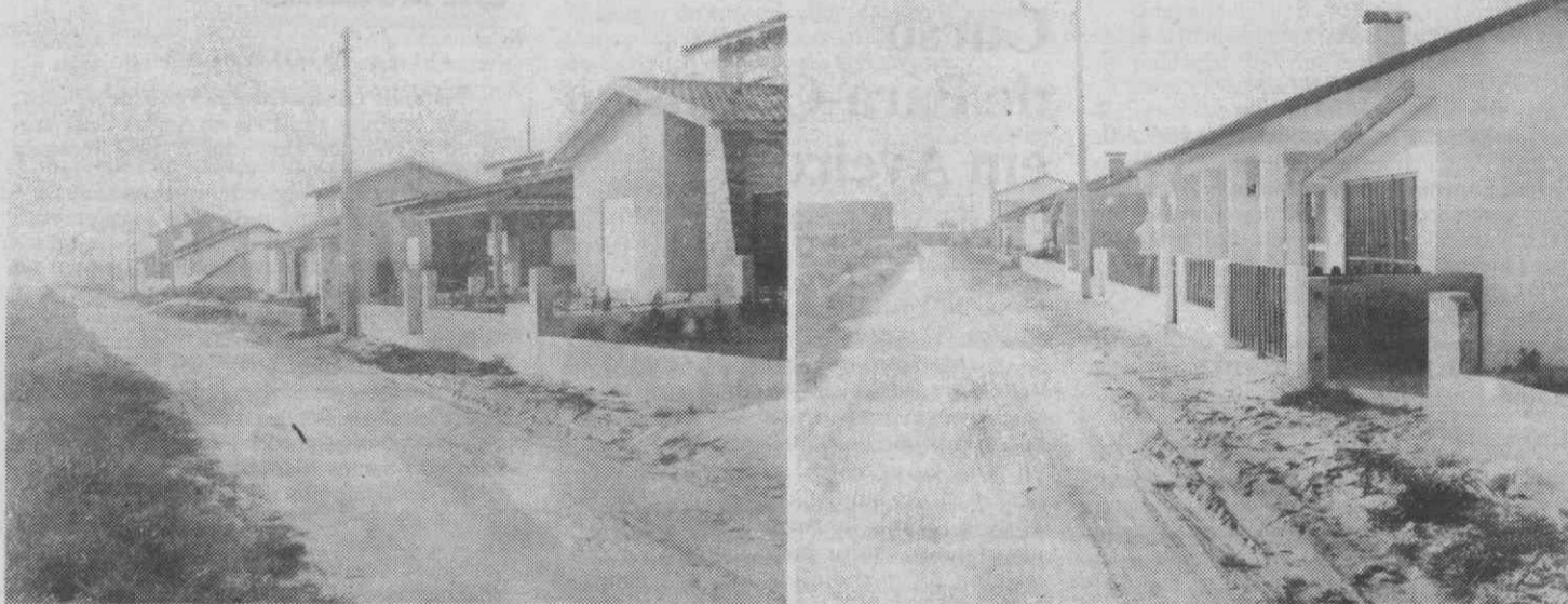
Ruas de João Louro e dos Pinheiros, a longa espera pelo asfalto.
